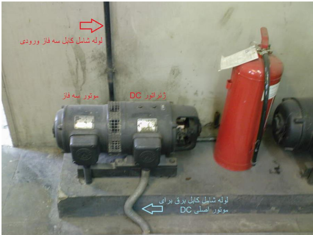
سیستم وارد - لنونارد برای کنترل سرعت آسانسور - امروزه از رده خارج و سیستم های جدید VVF جانشین آن شده است
